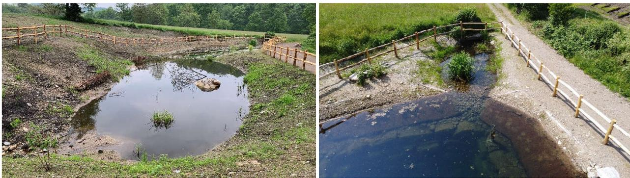
**Foto 4: Zona di pescaggio – Muro in blocchi, consolidamento scarpate con grate in legno e rete.**
