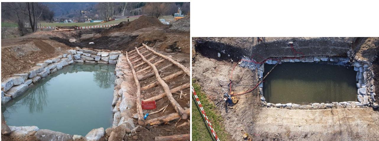
**Foto 5: Alimentazione pozza (prolungamento drenaggio esistente sul mappale 75 RFD Curio), pompaggio dell'acqua dalla pozza (posa tubo, pozzetto, controllo livello acqua (asta idrometrica) e troppo-pieno.**
